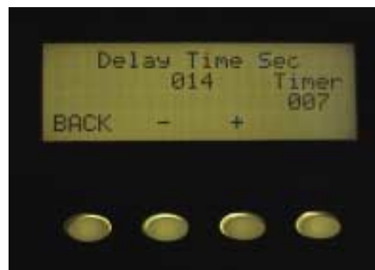
Bild 15 – Einstellung Verzögerung der Unterspannungsauslösung
